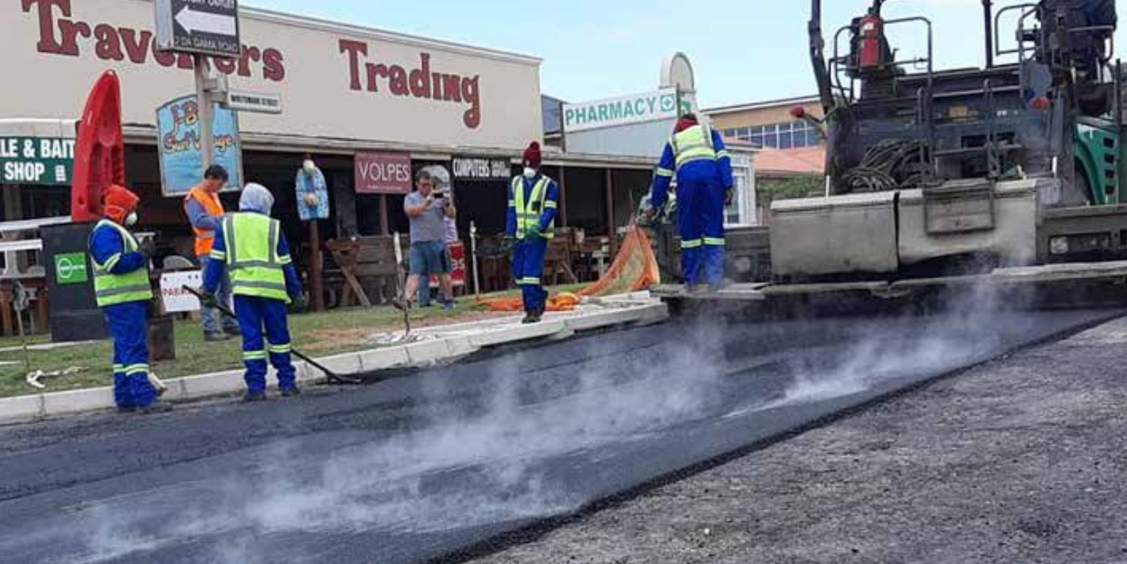
Foto: 'n Straat in Jeffreysbaai word herstel met plastiek.
